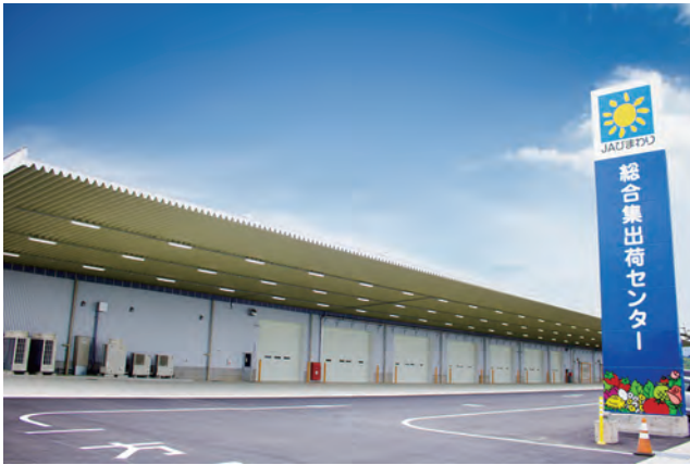
7月より稼働した総合集出荷センター
