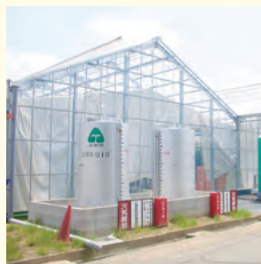
生産性向上対策支援事業を利用し新設されたハウス
